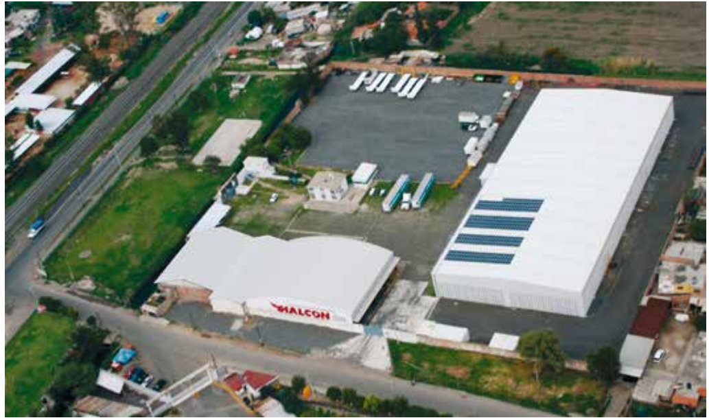
10 – Vista aérea de la planta I-Tech de Celaya (Guanajuato, México).
